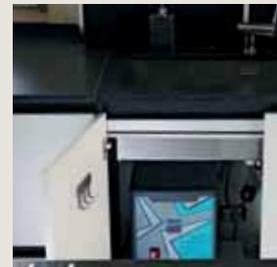
Die kompakten Abmessungen von Sistem Cube ermöglichen die Installation überall, auch in Möbeln. Der gewählte Raum kann ohne Belüftung sein, da der direkt gekühlte Motor die Luft aus den Ansaugstutzen nutzt.
